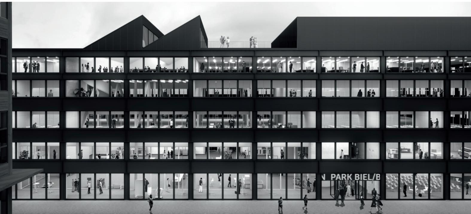
Das fünfstöckige Gebäude bietet eine Gesamtfläche von 15500 m² (BGF)
